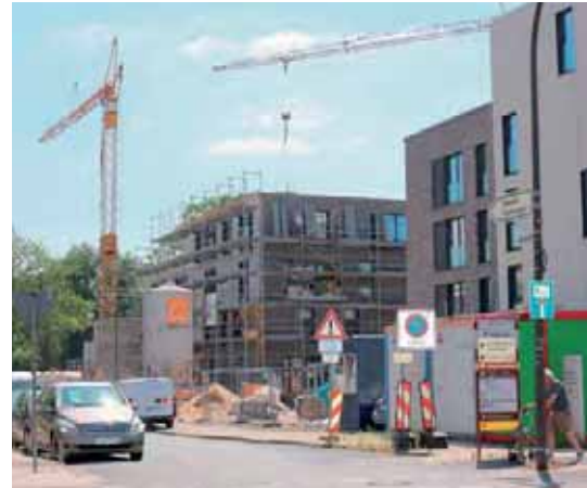
Abb. 2.7/9 Bautätigkeit im Bereich Eichenpark, Juni 2019
