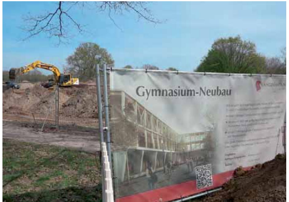
Abb. 1.2/5 Baustelle Gymnasium-Neubau Neue Bult
