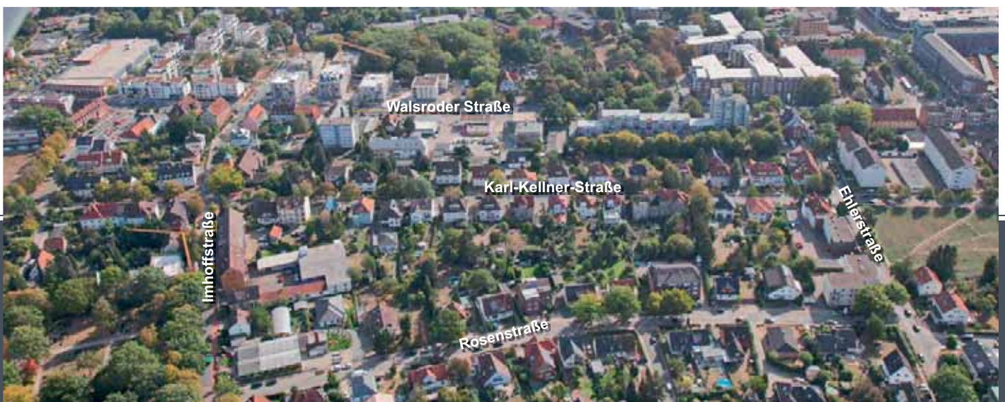
Abb. 2.7/13 Nachverdichtung durch Abriss von EFH und Neubau von MFH, Blick von Westen auf den Bereich Rosenstraße
