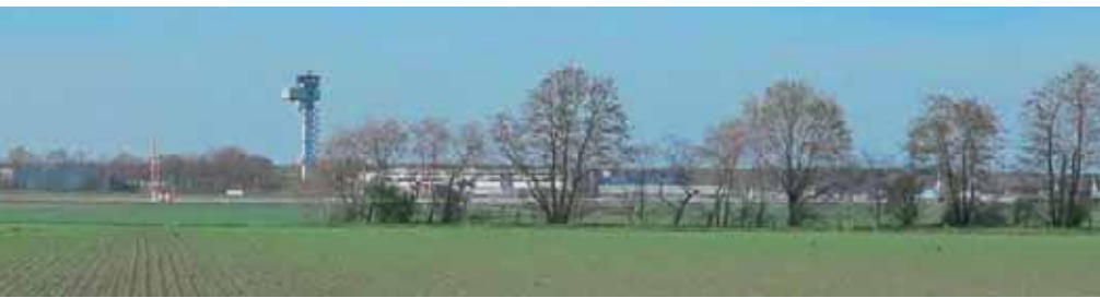
Abb. 2.2/2 Blick auf den Flughafentower, Godshorn
