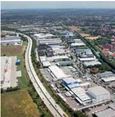
Abb. 4.2/2 Gewerbegebiet in Godshorn
