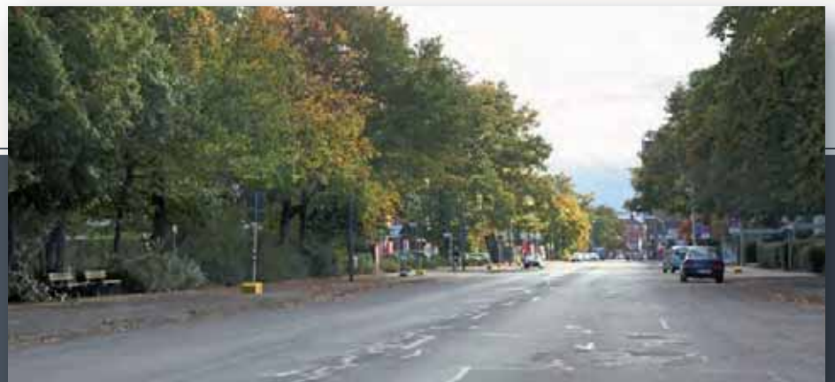
Abb. 4.3/9 Walsroder Straße mit überbreiter Fahrbahn, Querungshilfen fehlen
