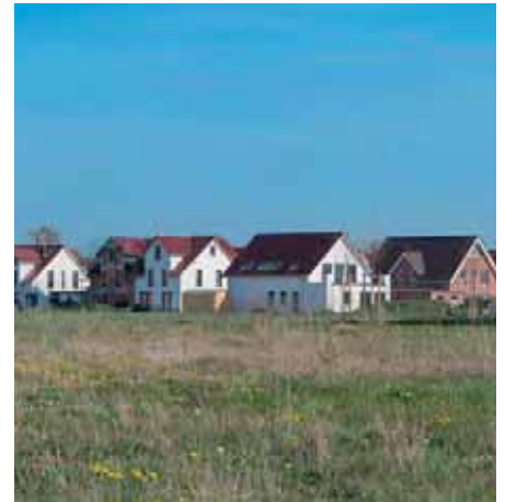
Abb. 1.3/2 Neubau am Siedlungsrand
