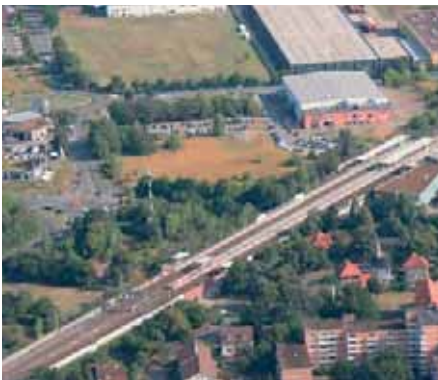
Abb. 4.2/12 Potentieller Standort für Büro und Dienstleistungen, Brüsseler Straße
