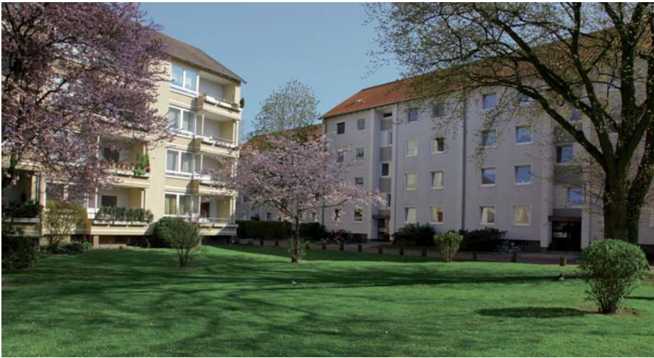
Abb. 8.0/3 Modernisierter Wohnungsbestand in der Gladiolenstraße, Langenhagen
