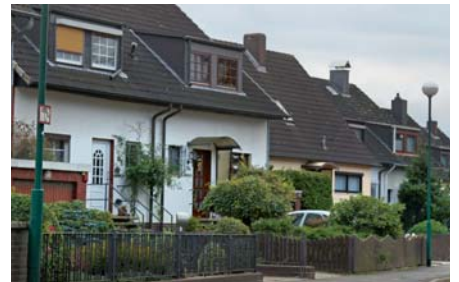
Abb. 7.3/2+3 Verschiedene Baustrukturen in Krähenwinkel
