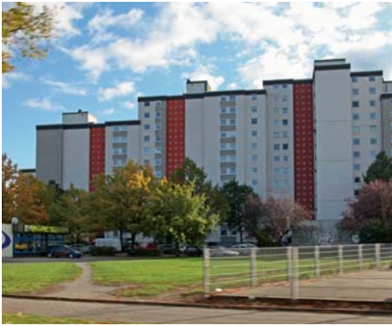
Abb. 7.2/2 Modernisierte Mehrfamilienhäuser am Söseweg in Langenforth
