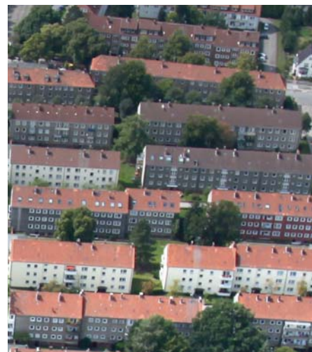
Abb. 8.0/1 Modernisierungsbedürftiger Wohnungsbestand der Bahnhofstraße in Langenhagen
