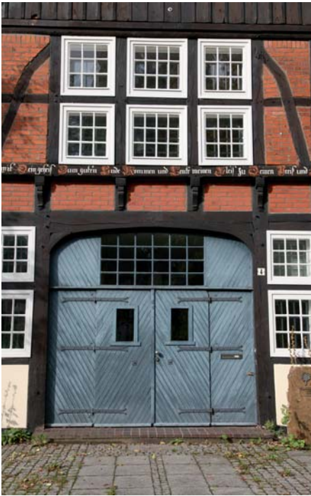
Abb. 8.2/1 Umgenutzte Hofgebäude in Godshorn
